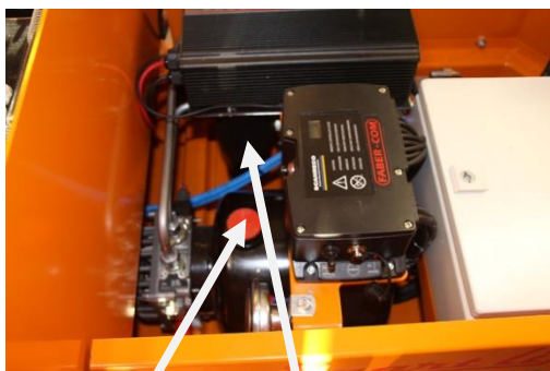
Hydraulikkbeholder og trykkfilter
